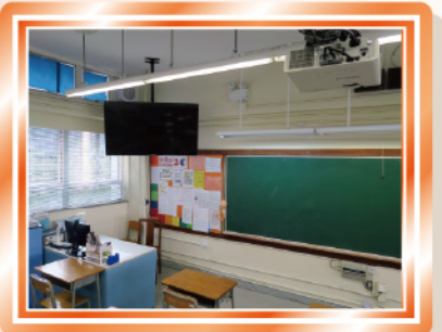
課室電子設備
